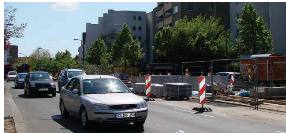
Baustelle für den neuen Ausgang
