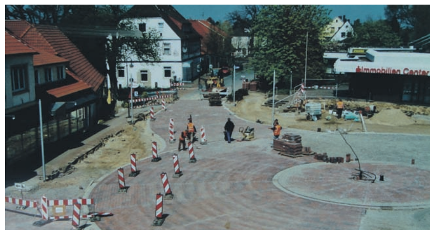
Bauarbeiten für einen großen Kreisverkehr im Zuge von Shared space
